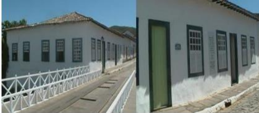
Figura 1: Fotos da fachada
